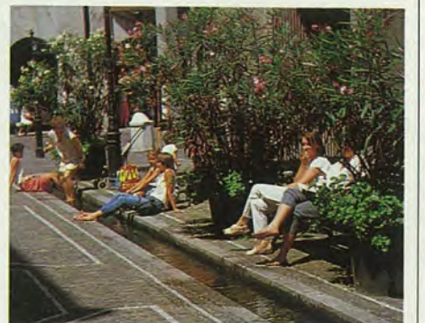
Straßengraben. Gleichzeitig Hochwasserüberlauf. Gestaltete Technik.
