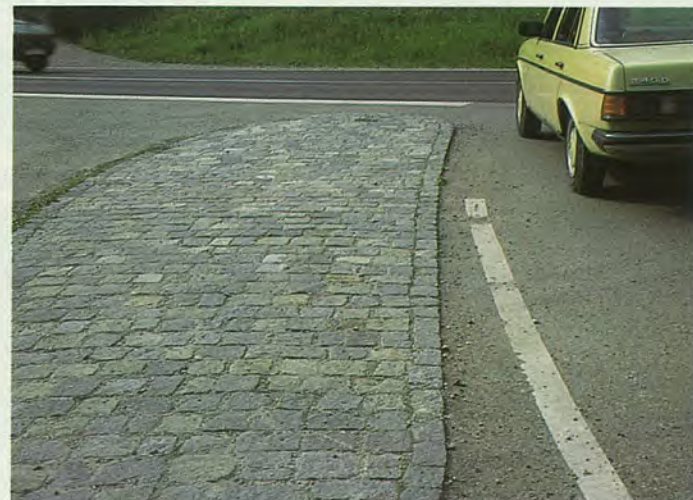
Überfahrbare Inseln verlangsamen und schützen vor dem PKW-Verkehr. Große Lastwagen können sie mitbenutzen. Eine Art Hochwasserzone. Am Rande des Stroms.
